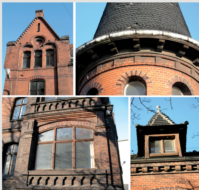
Il. 4. Ceramiczne kształtki i dekoracyjne wertykalne podziały elewacji budynku zarządu Browaru i zarządu Słodowni.
